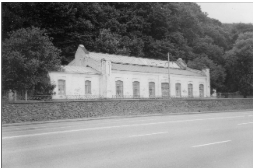
Рис. 1. Водопровідна насосна станція Південно-Західної залізниці на Набережному шосе; поч. XX ст. Фото 2007 р.
